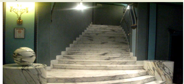
Dettagli, come le scale, che paiono in marmo, sono in realtà fatte di cartongesso
